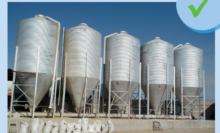
Silos em boas condições
