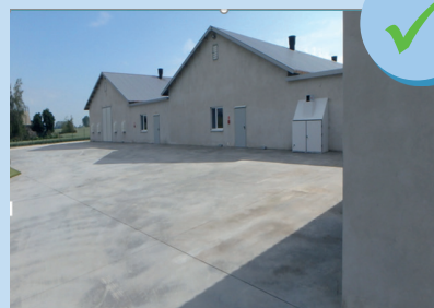
Zona adjacente cimentada
