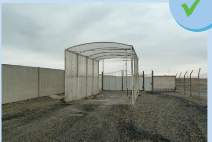
Túnel de desinfecção para veículos
