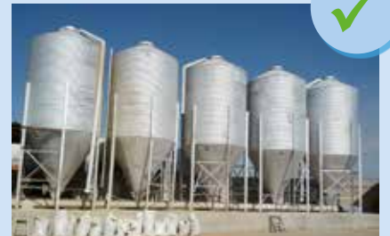
Silos em boas condições
